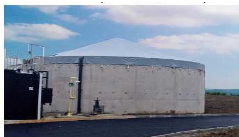
Exemple de cuve béton couverte
